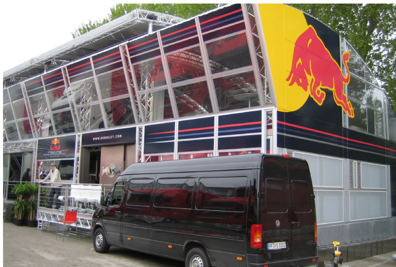
„intraService“ entwickelte das Vernetzungskonzept für die Energy Station. Foto: Nigg
